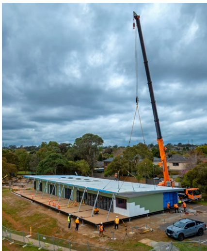
Brandon Park Reserve新场馆采用模块化方式建造, 现已开放使用。
